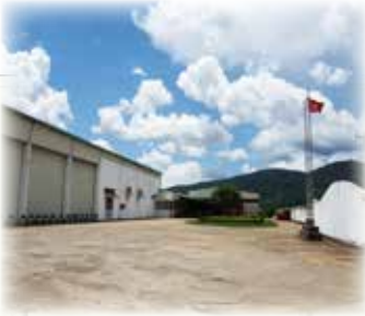
KHU VỰC NHÀ MÁY FACTORY AREA
